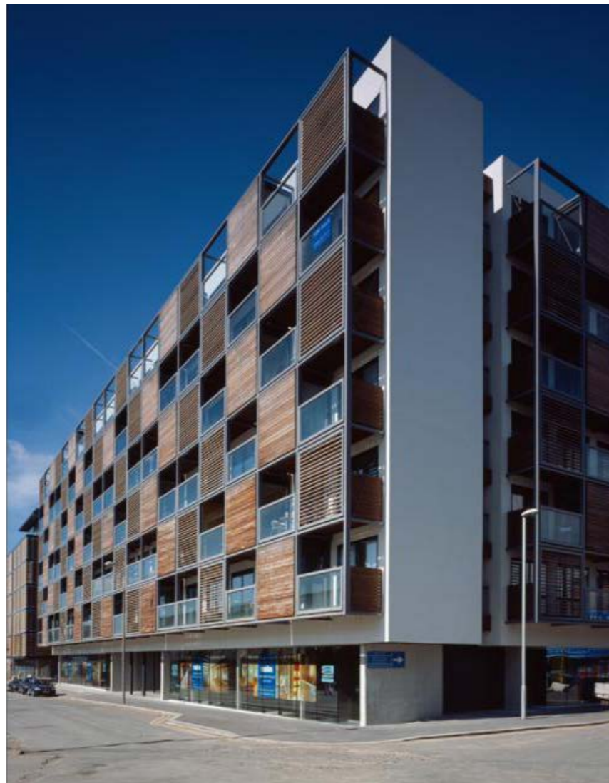
Fig.91 Fotografia del fronte strada, Moho Apartments.
