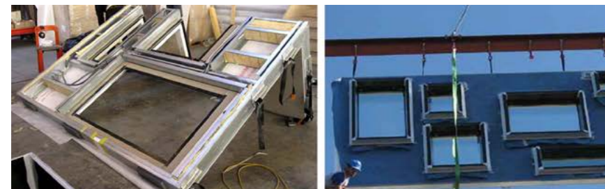
Fig.115 Fotografie del sistema costruttivo tipo "Cocoon" e della posa di una cellula prefabbricata, progetto MOHO.
