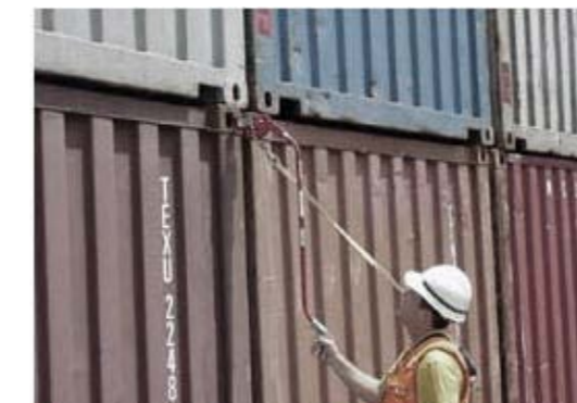
Fig.281 Fissaggio dispositivi di ancoraggio.
