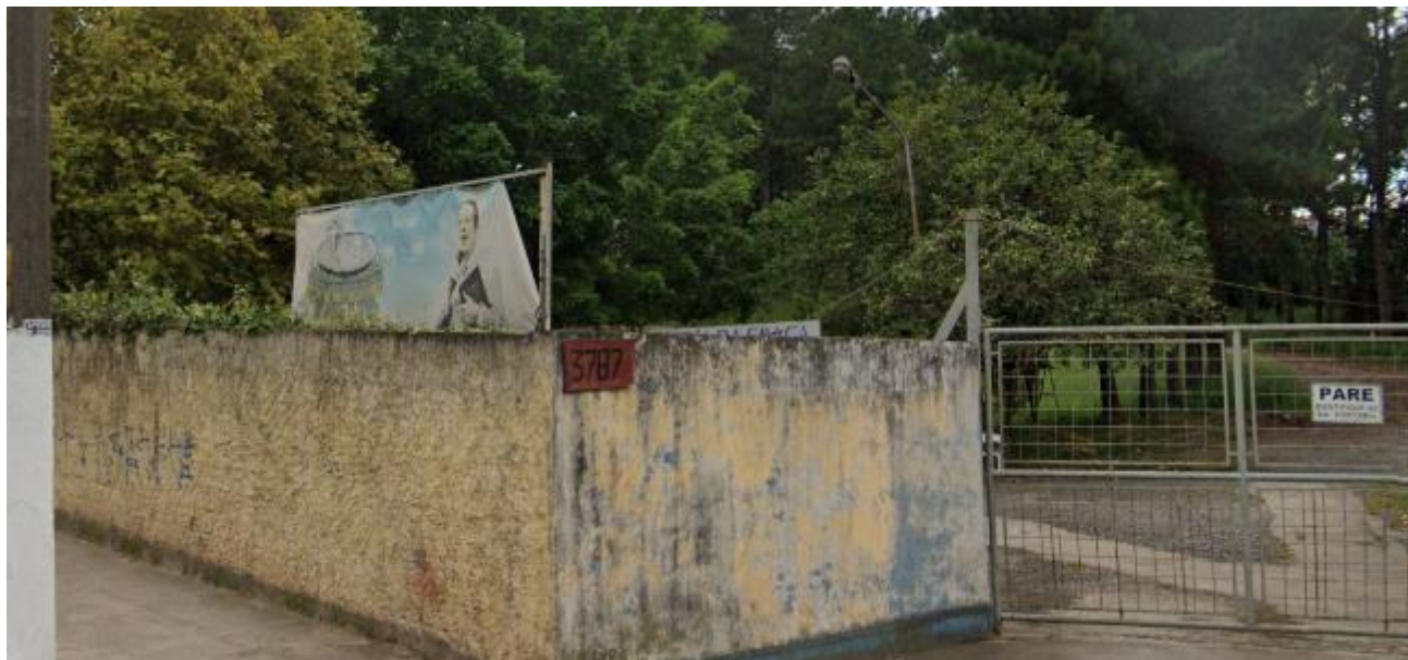
Foto 7 - Fachada atual do imóvel localizado na Av. Jacu-Pêssego nº 3787.
