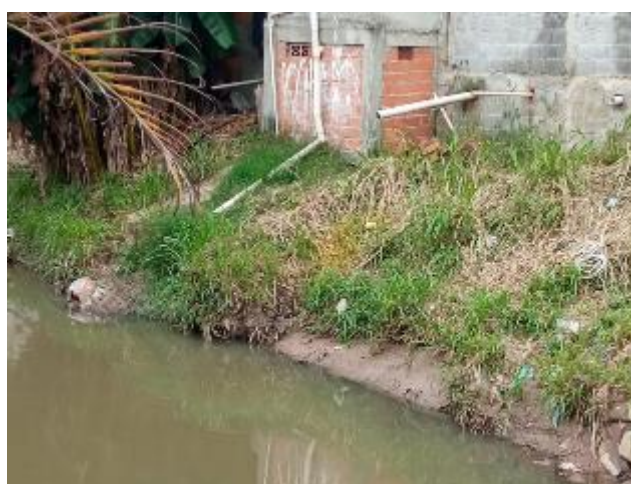
Foto 2 – Encanamentos posicionados para o despejo de efluentes sanitários diretamente no Rio Aricanduva
