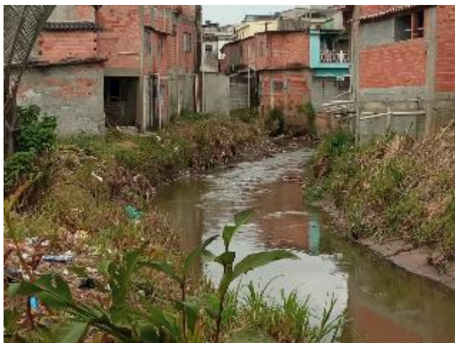
Foto 3 – Vista do Rio Aricanduva com margens completamente ocupadas por edificações residenciais de baixo padrão em alvenaria
