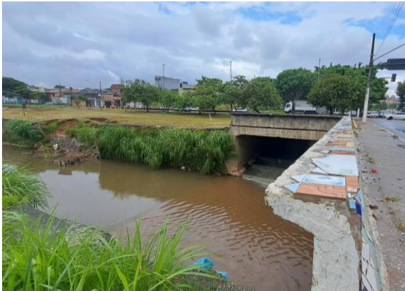
Imagem 2 - Afluentes dos Machados no rio Aricanduva
