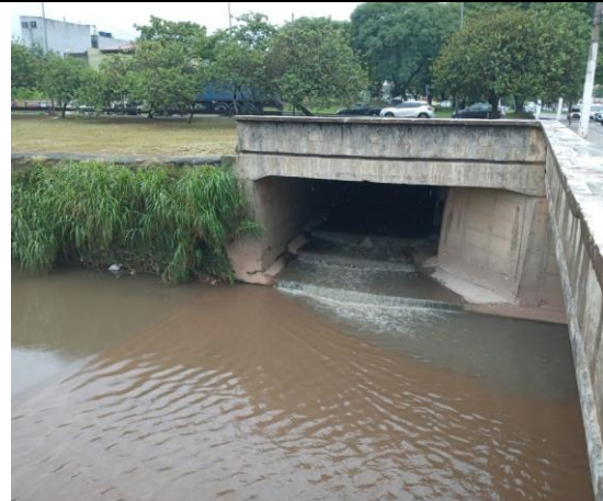
Imagem 19 - Área de implantação do reservatório. Observar a APP na confluência das águas do Rio das Pedras e do rio Aricanduva, estas águas serão recebidas pelo Reservatório Machados RMA- 1.
