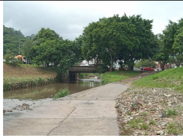
Imagem 18 - Área de implantação do reservatório. Observar estrada de serviço, travessia e vegetação arbórea a ser manejada incidindo sobre a APP.
