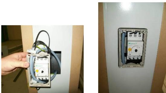
7. Die Blende auf den Einbaurahmen aufsetzen und verschrauben.
