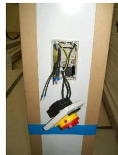
9. Zur einfachen Montage die beiden Kabel, wie auf dem Bild zusehen ist, zueinander mit einem Kabelbinder fixieren. Anschließend die Kabel nach hinten in die Säule schieben und die Blende auf den Einbaurahmen aufsetzen und festschrauben.
