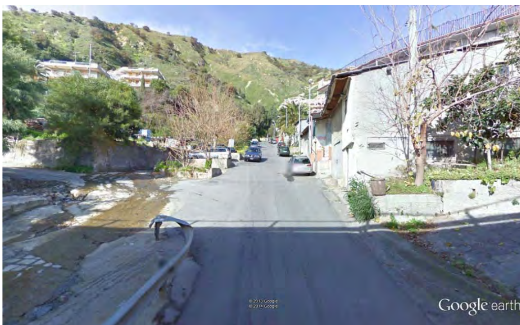
Letojanni (ME): 37.888504°, 15.314275° - alveo di torrente del 2° ordine quasi interamente occupato da una strada
