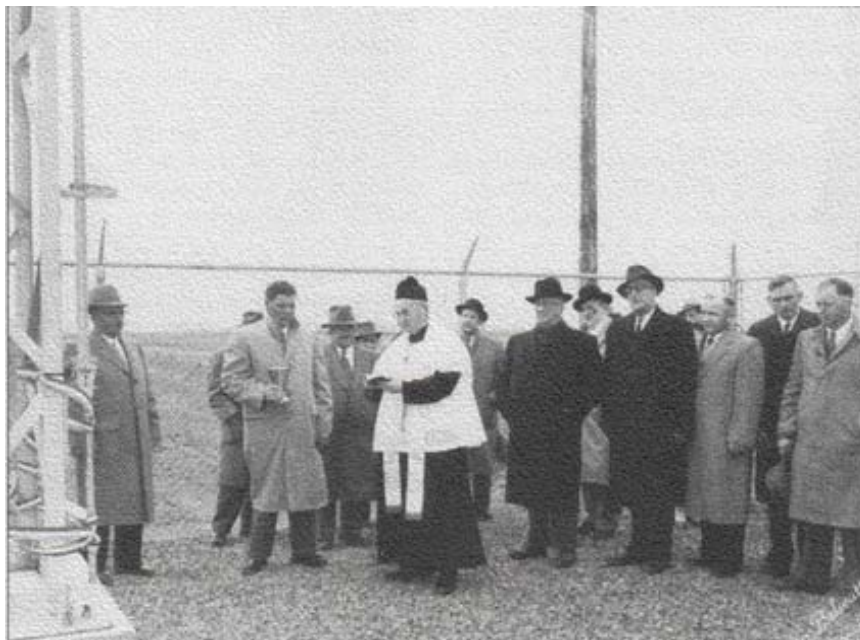
Bénédictio d'un des postes du réseau électrique
