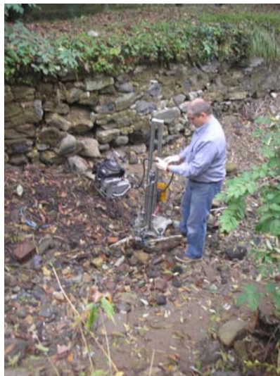
Figura. III.107. Esecuzione della prova penetrometrica all'interno del canale secco.
