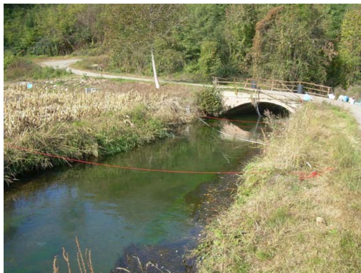
Figura III.137. Tratto del canale in cui è stata svolta l'indagine.
