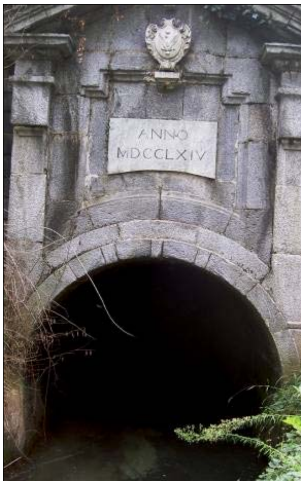
Figura. III.1. Imbocco del tratto in galleria a monte di San Giorgio Canavese costruito nel 1764.
