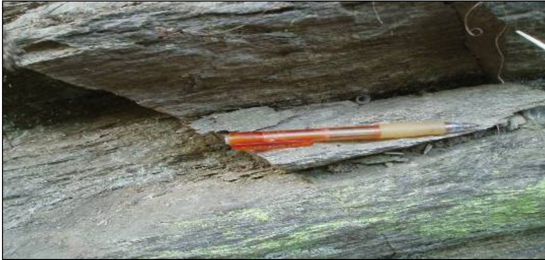
Figura III.48. Metadioriti di Malanaggio a sud di Bric di Castello.
