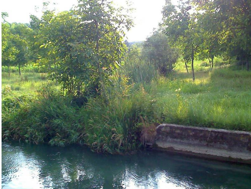
Figura IV.12. Zona umida con immissario nel tratto di canale investigato in corrispondenza dell'interruzione del rivestimento in cemento della sponda e concordante con la progressiva a 130m della figura precedente.
