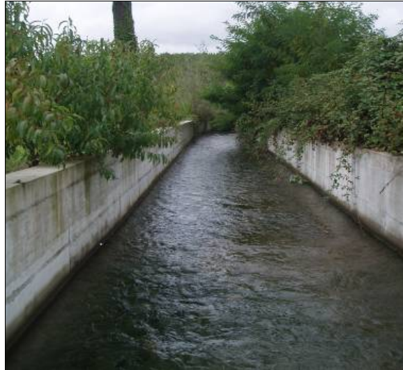
Figura III.55. Tratto di canale rivestito in calcestruzzo a nord-ovest di Cascina dei Battitori.
