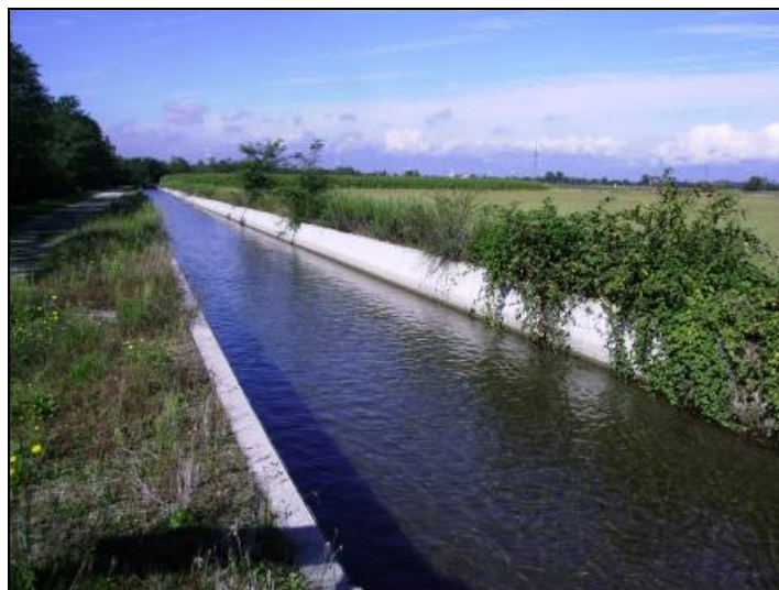
Figura III.9. Tratto in alveo cementato del Canale di Caluso situato in frazione Tonengo.
