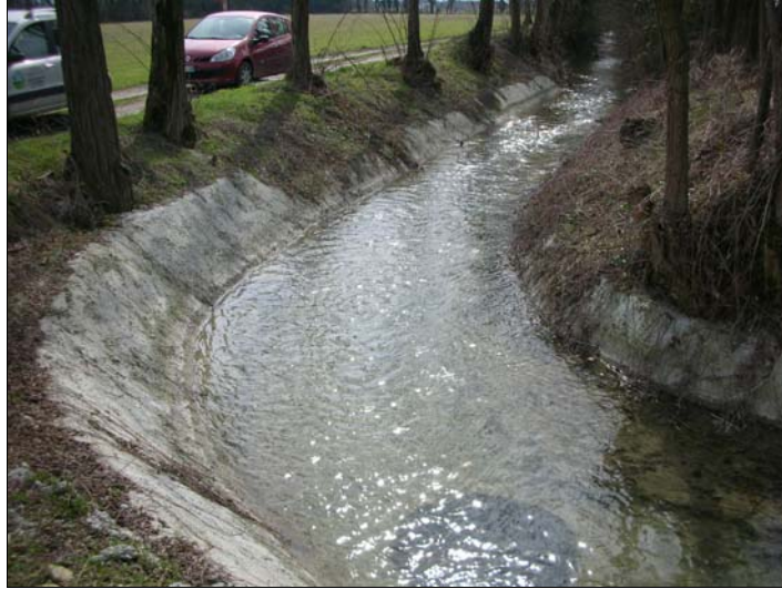
Figura III.153. Tratto di canale rivestito in calcestruzzo della Roggia Fraschetta.
