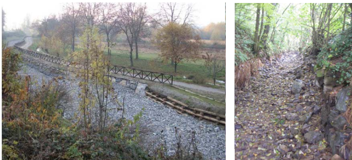
Figure III.86 e 87. Tratti di canale ad alveo ciottolato con sponde in materiale naturale, legno e blocchi.
