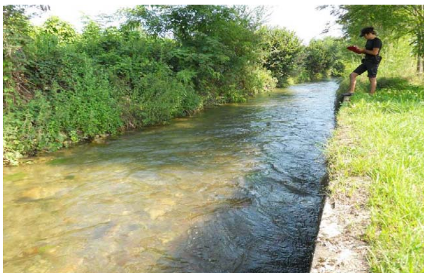
Figura III.119. Sponde del canale: alla destra è visibile la parte cementata, alla sinistra la parte naturale.
