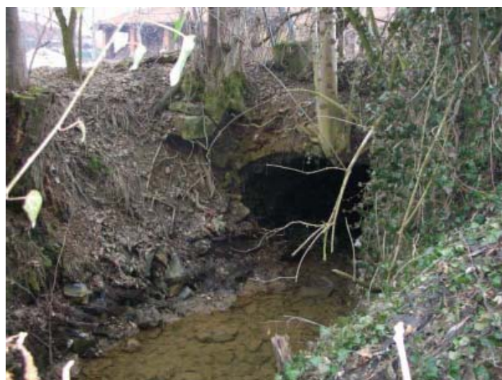
Figura III.88. Inizio di uno dei tratti intubati.
