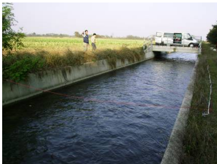
Figura III.30. Tratto del canale in cui è stato utilizzato il metodo dei galleggianti.
