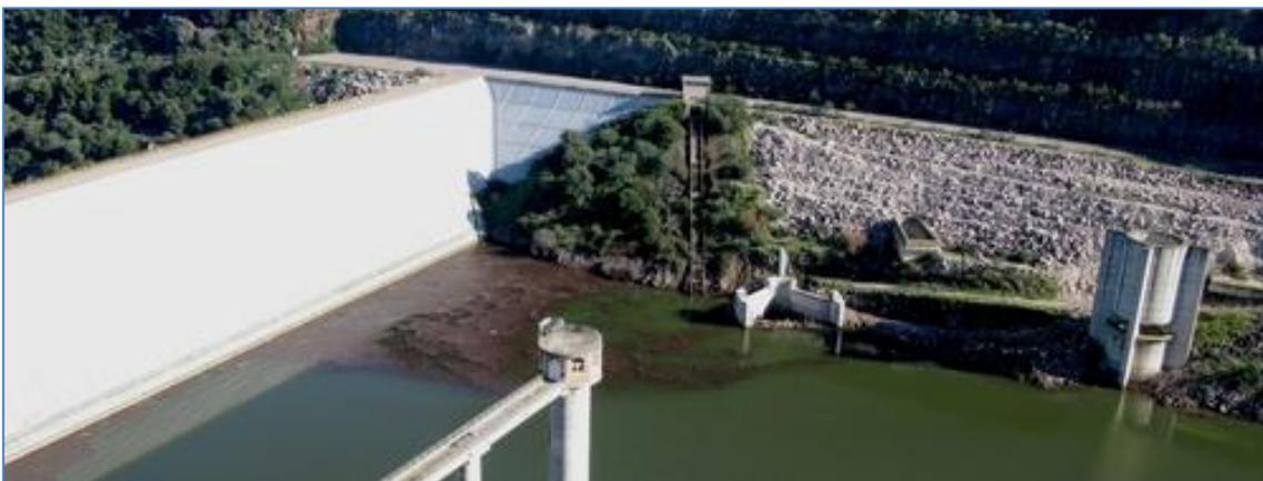
Figura 2.5 – Vista scarichi di superficie nella configurazione attuale
