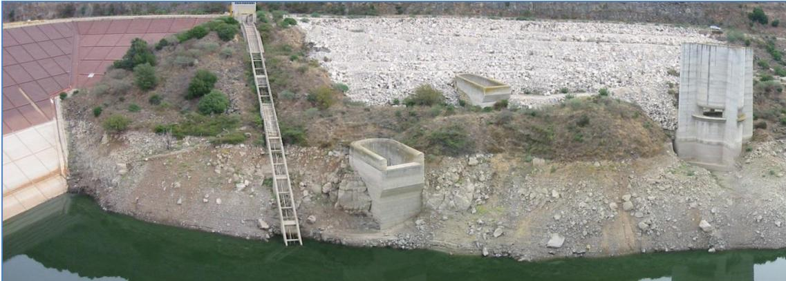
Figura 2.4 – Vista scarichi di superficie nella configurazione antecedente i lavori di modifica dello scarico inferiore (posto sulla sinistra)
