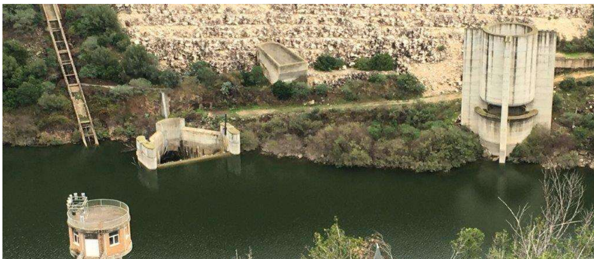
Figura 10–Vista degli scarichi di superficie in sponda destra
