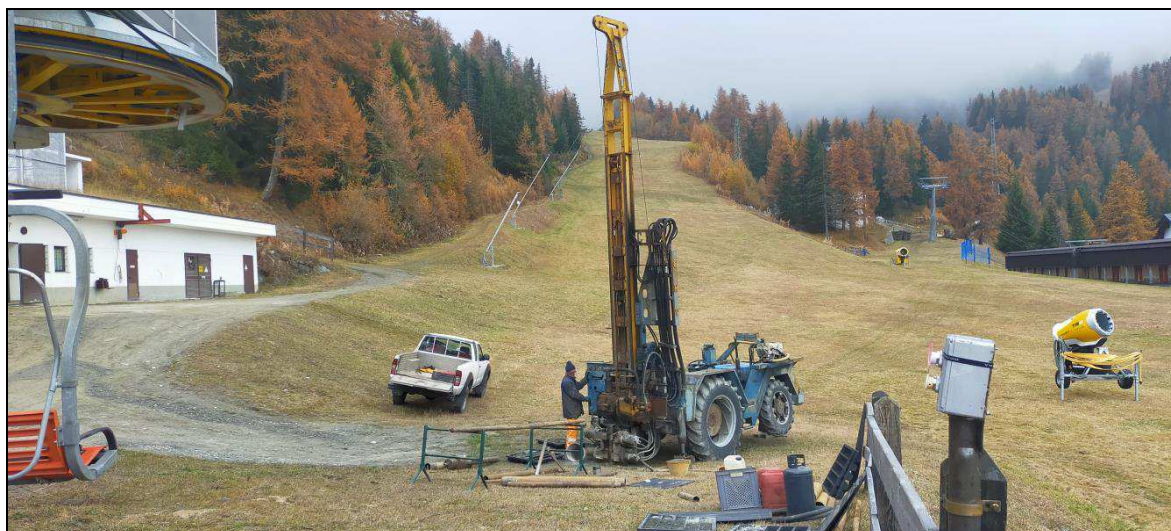
Sonda perforatrice CMV “MK 900 GL” – Sondaggio Intermedia 1
