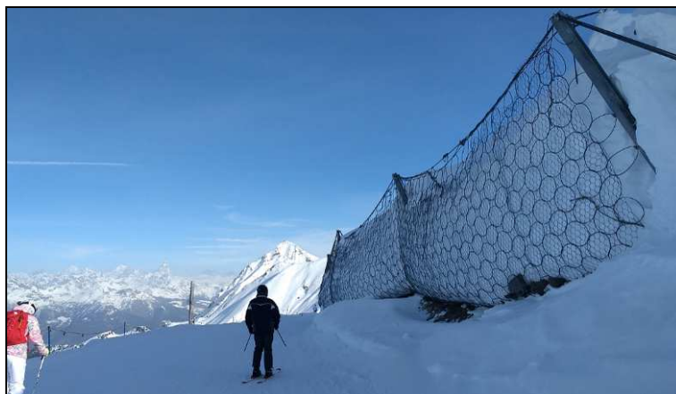
Barriere paramassi con funzione anche di fermaneve
