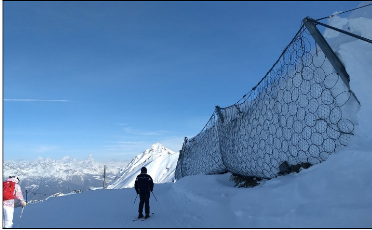
Barriere paramassi con funzione anche di fermaneve
