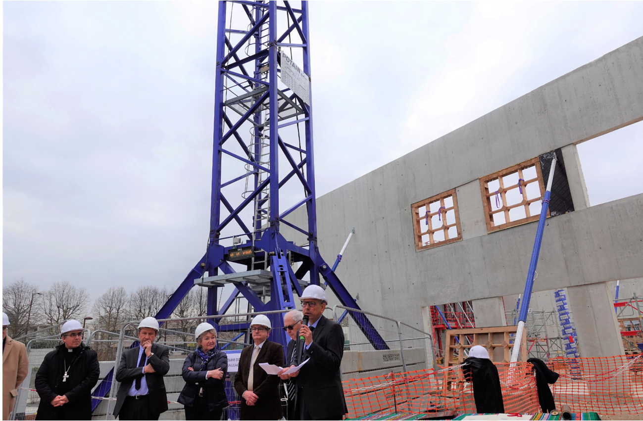
Le chantier du futur collège de Saint-Julien-les Villas utilise des techniques de construction nouvelles.
