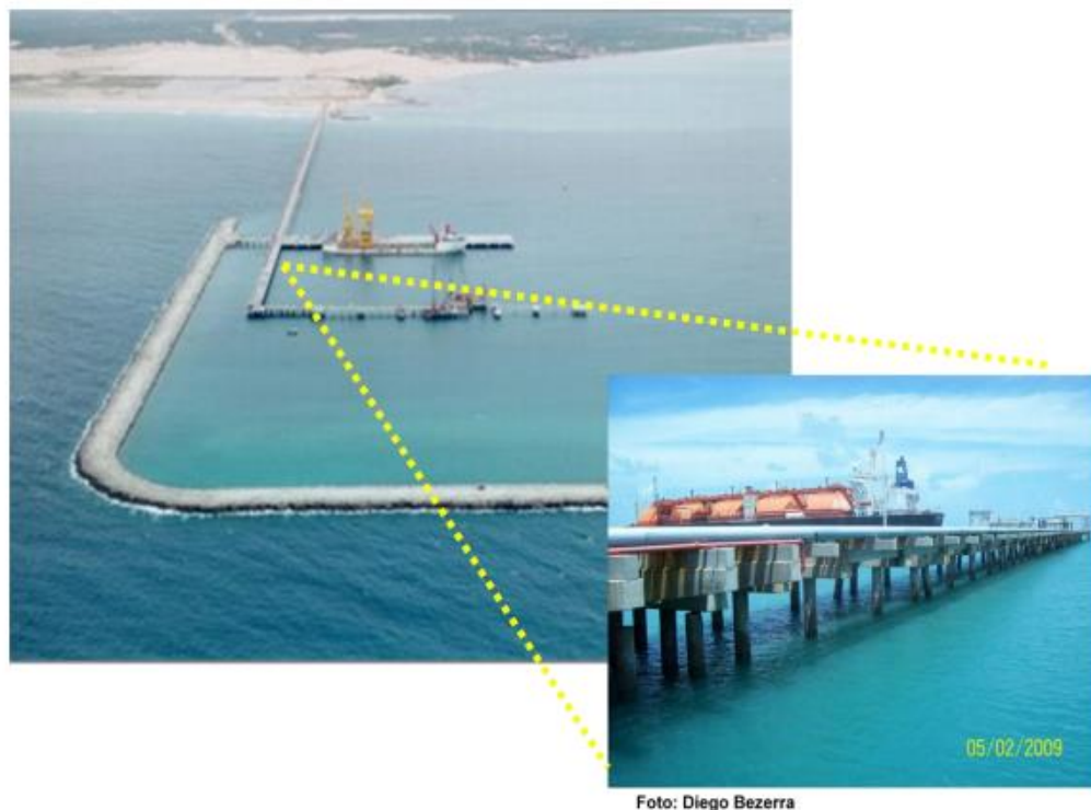
Figura 3: Vista aérea do Terminal do Portuário do Pecém apontando o local de amostragem.
