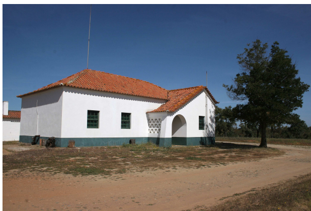
Figura 6 - Casa do guarda-florestal
