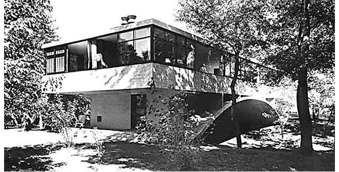
Casa del Puente, Mar del Plata, Bs.As. (1943-6) A. Willians
