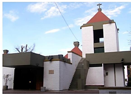
Vista lateral esquina
