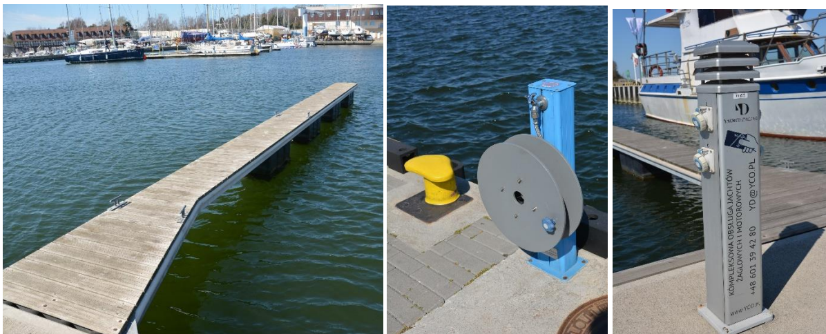
Rys.17. Pomost oraz elementy infrastruktury: hydrant i skrzynka elektryczna
