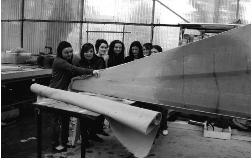
COLOCACIÓN E TENSADO DA TEA DE ARPILLEIRA
