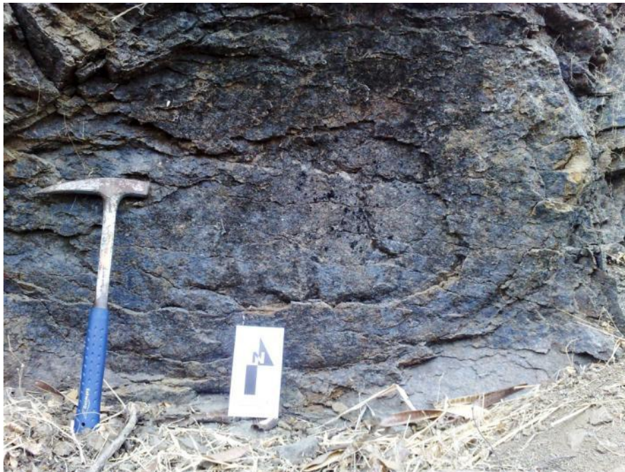
Figura 11.11. Meteorización de capas de areniscas de la Formación Socorro en la autopista Guayaquil – Salinas (Foto tomada en salida de práctica de campo de la materia Estratigrafía y Sedimentación, por el estudiante de Ingeniería en Geología David Altamirano, el 18 de diciembre de 2009).
