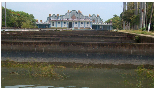
Figura 3.3.- Instalaciones de la Granja Acuícola Tancol, en Tampico, Tamps.
