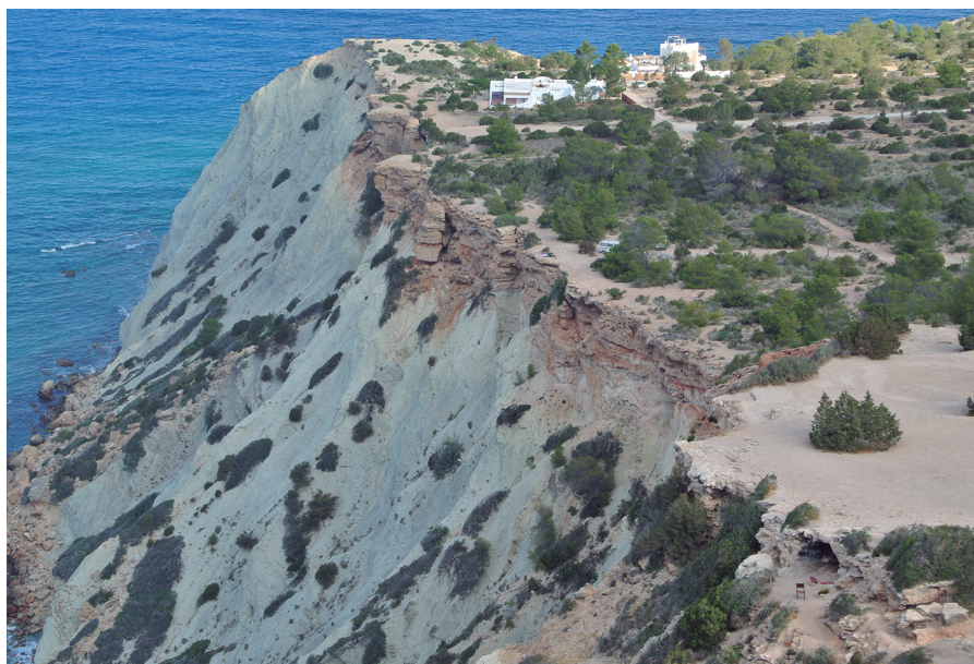
Algunes de les construccions en una zona considerada de risc de Cala d'Hort, antiga part del Parc Natural de Cala d'Hort, Cala Llentrisca i sa Talaia; terreny desqualificat a partir de la Llei 10/2003 (fotografia: Laura del Valle).
