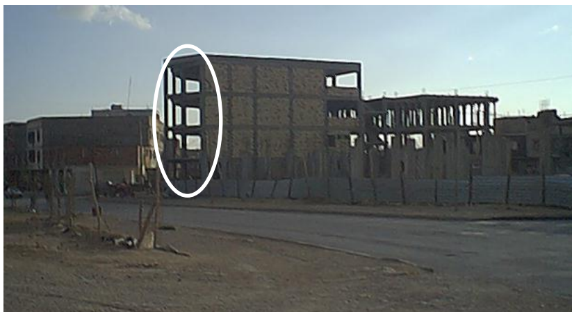
Photo n° 16 dépassement des hauteurs
