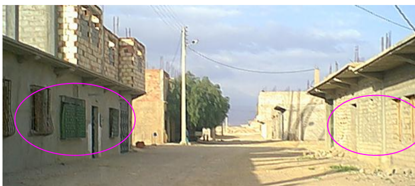
Photo n° 17 Abolition de la véranda
