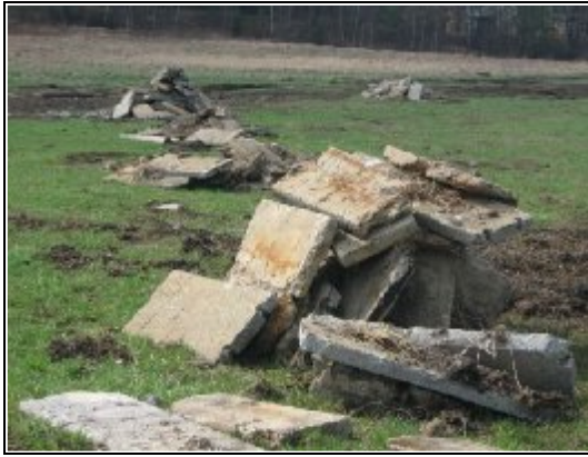
Obr. 4 Revitalizované koryto Svinického potoka, a) odstraněné betonového opevnění, b) rozvolnění koryta zaslepení podpovrchové drenáže – stav jaro 2005. Foto: Matoušková
