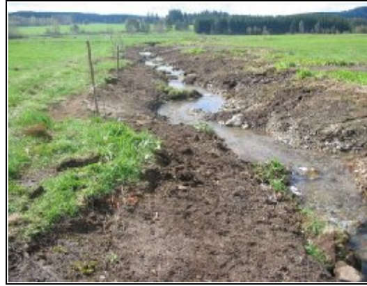
Obr. 4 Revitalizované koryto Svinického potoka, a) odstraněné betonového opevnění, b) rozvolnění koryta zaslepení podpovrchové drenáže – stav jaro 2005. Foto: Matoušková
