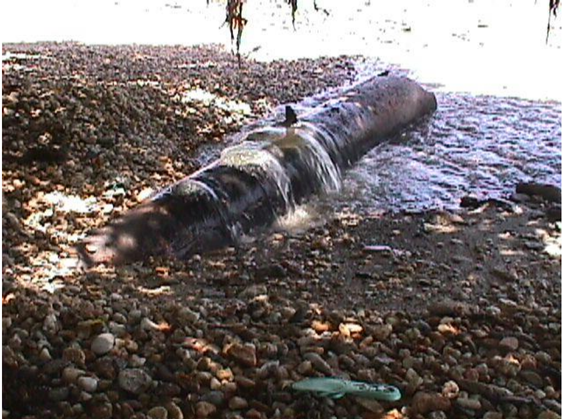
Foto I-10.- Tubería de aguas servidas en la que se aprecia la salida de las aguas directamente en la zona litoral de la playa situada al sur de Güiria.
