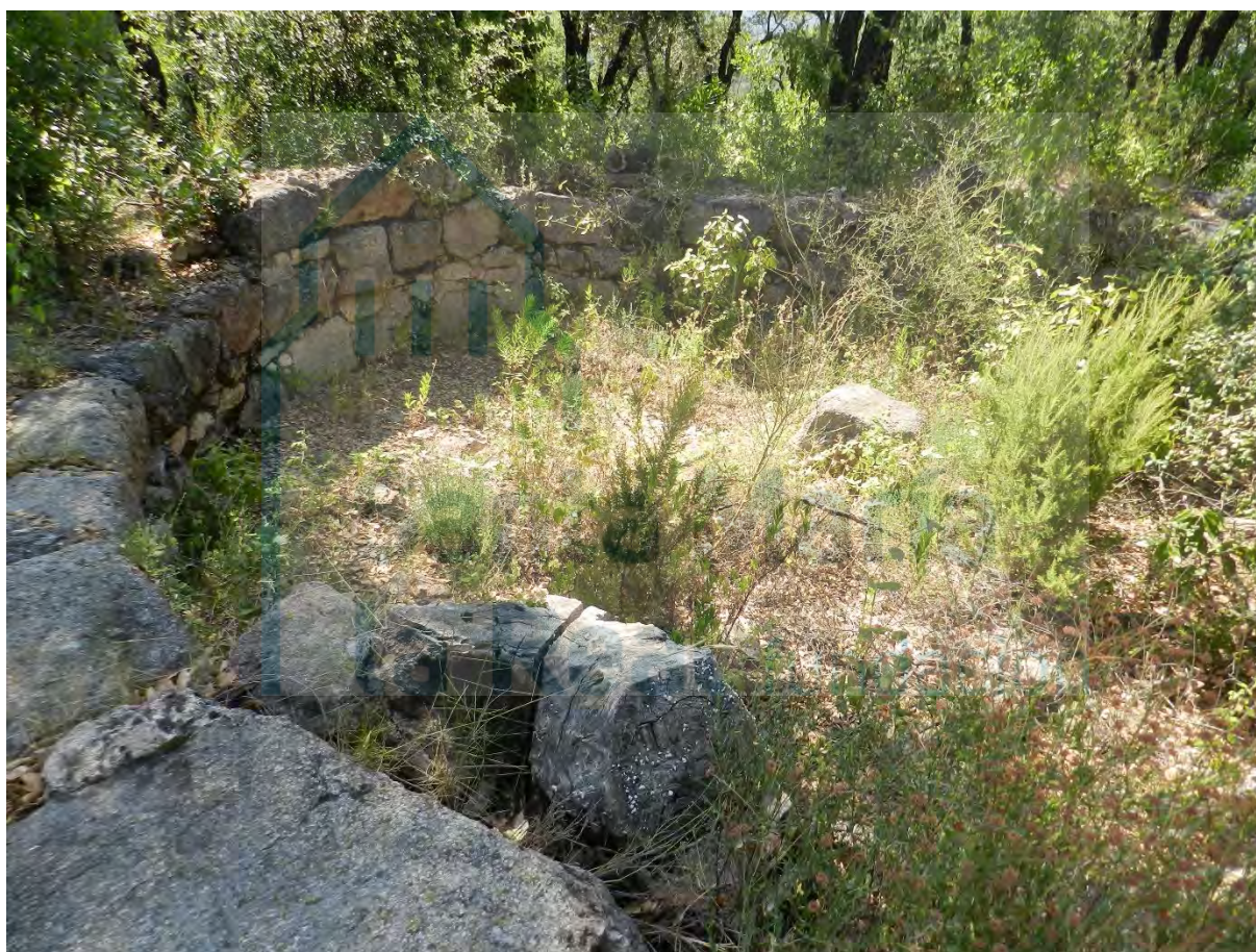
Restos de la torre
