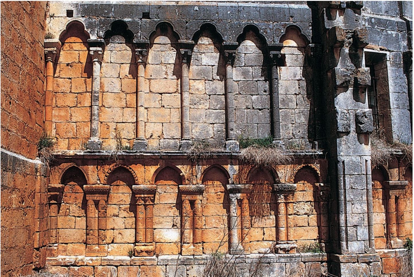
Arquerías del muro sur del presbiterio
