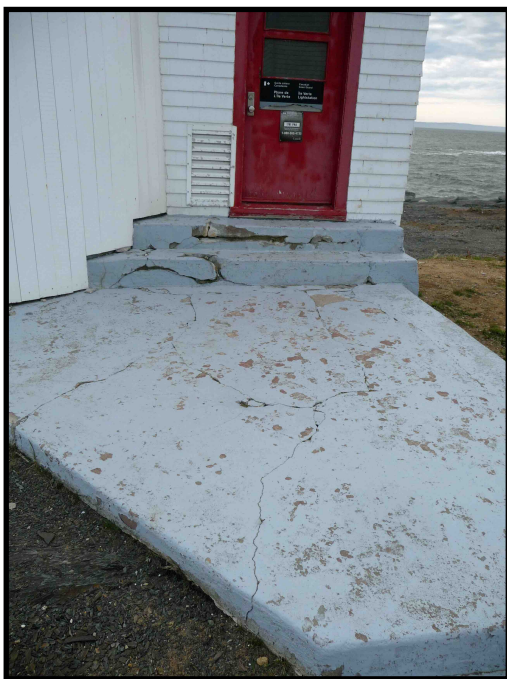
L'entrée du phare avant les travaux Photo : Jean Cloutier
