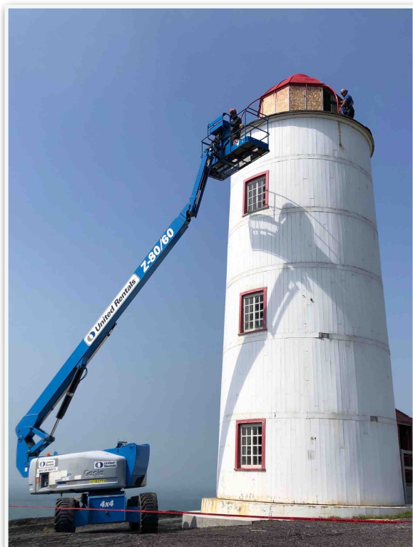
Réfection de la lanterne Photos : Louise Newbury
