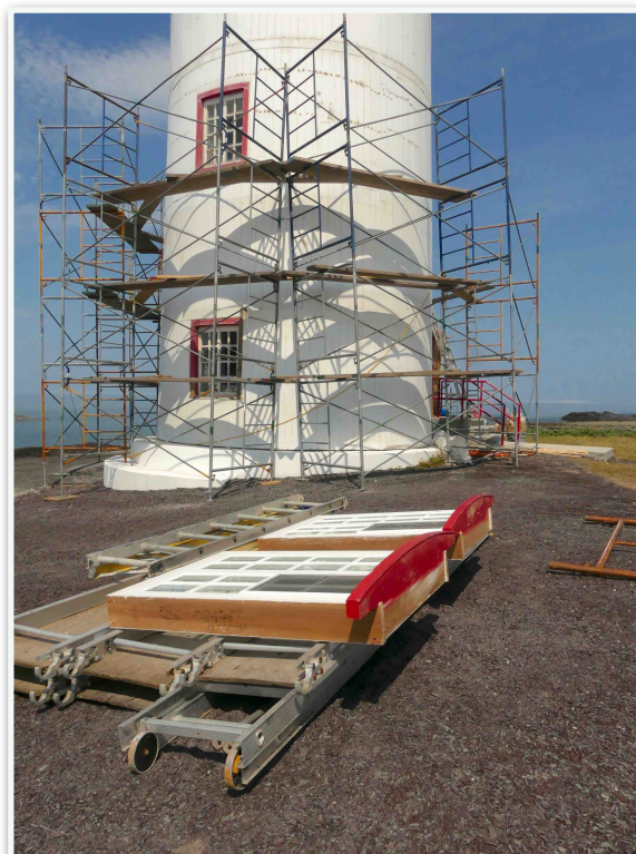
Préparatifs pour l'installation des fenêtres Photo : Jean Cloutier
