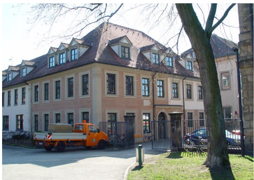
Auch ein Eingang zum IT-Betreuungszentrum Halbmondstraße (IZH).
