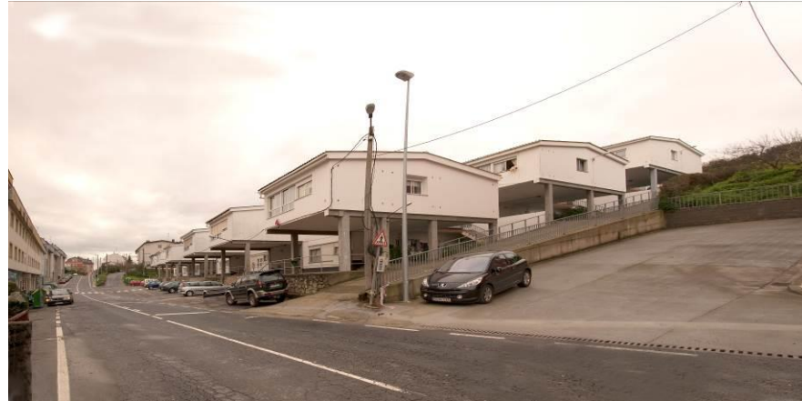
Urbanización en Fontán
