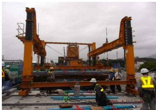
【新しい床版の設置】
