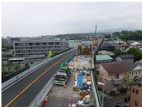
【床版取替工事 全景】
