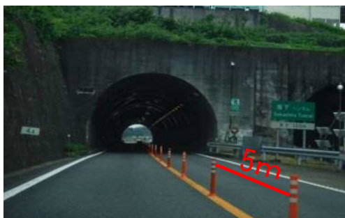
【ポストコーン設置状況 (昼間)】
