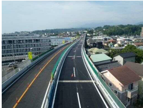
【床版取替完了後】
