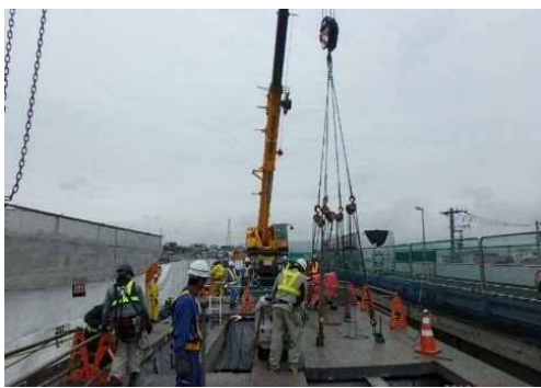
【老朽化した床版の撤去】
