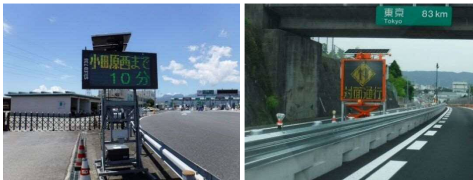
【簡易LED情報板設置状況】
