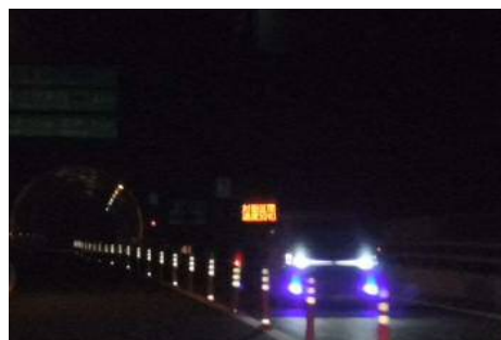
【ポストコーン設置状況 (夜間)】
