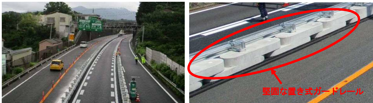
【2018小田厚リリニューアル工事 置き式ガードレール設置状況】
