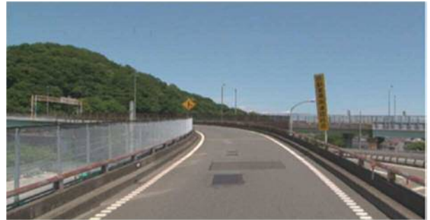
既存床版の損傷状況
