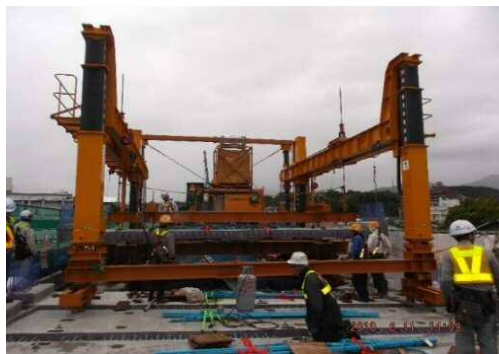
【新しい床版の設置】
