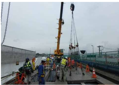
【老朽化した床版の撤去】
