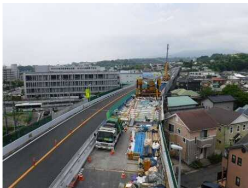
【床版取替工事 全景】
