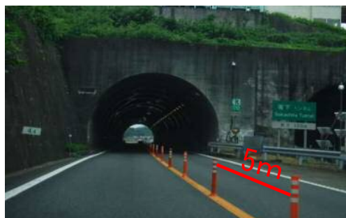
【ポストコーン設置状況（昼間）】
