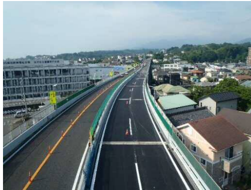
【床版取替完了後】
