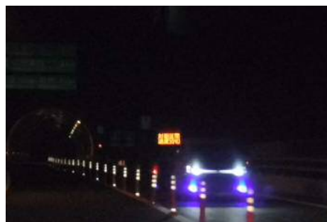
【ポストコーン設置状況（夜間）】
