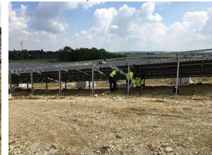
Photo 12 : Mise en place de panneaux
