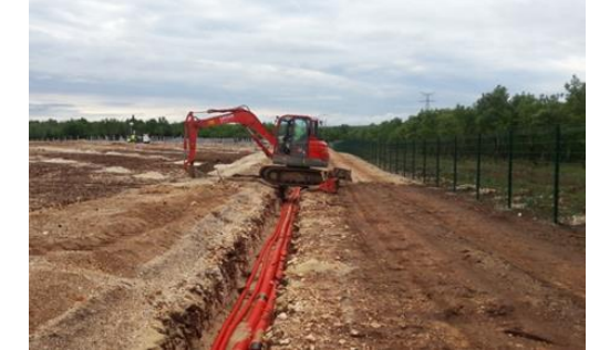
Photo 10 : Enfouissement de câbles électriques HTA
