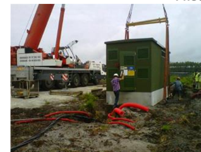
Photo 13 : Déchargement d'un PDL
