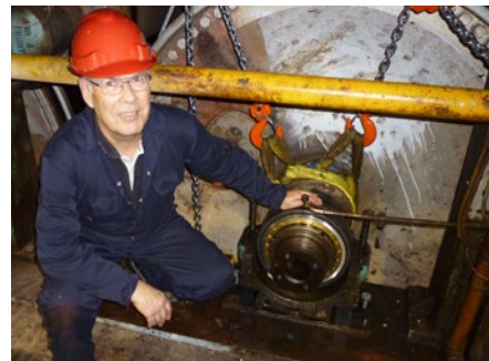
Montagearbeiten am Trockenzyylinder
