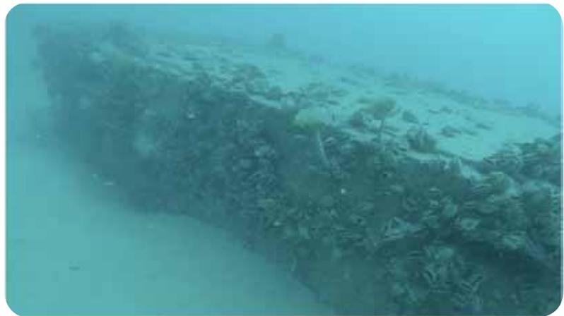
Fig. 4 - Ambedue le fiancate del manufatto testimoniano la completa copertura di epibionti ottenuta con l'uso di un impasto cementizia di tipo speciale *environmental friendly*, che ha consentito l'insediamento della biocenosi in tempi particolarmente brevi.
