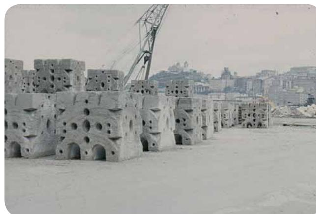
Fig. 2 - Blocchi di calcestruzzo pronti in banchina per essere imbarcati ed essere trasportati nella zona di ripopolamento.
