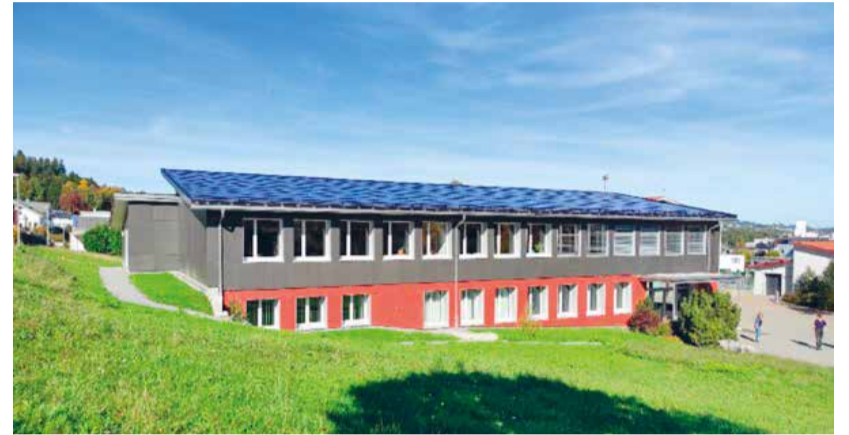
Während der Sommerferien ist das Schulhaus Busswil saniert worden.
