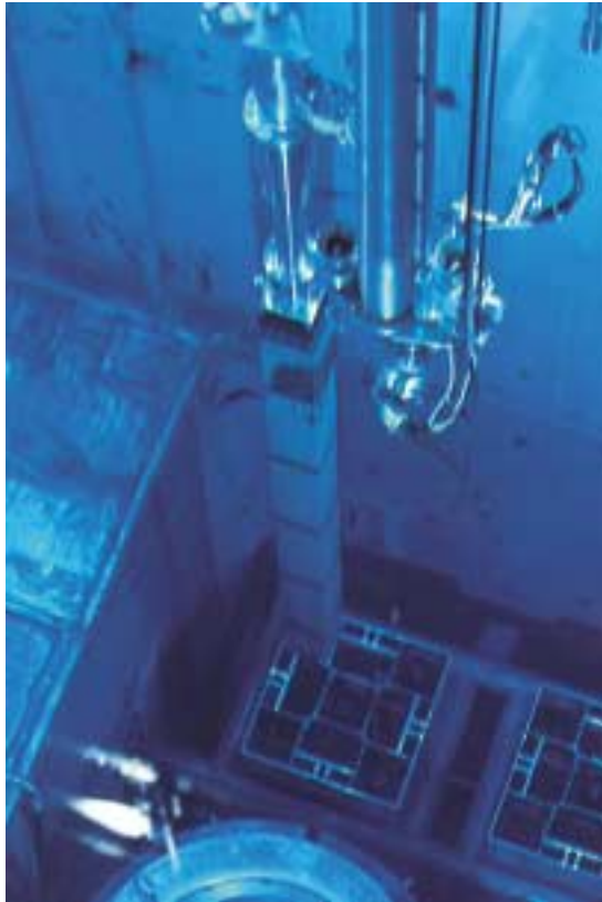
Figur 2-2. I bassängerna i CLAB mellanlagras det använda kärnbränslet från alla de svenska kärnkraftverken.
