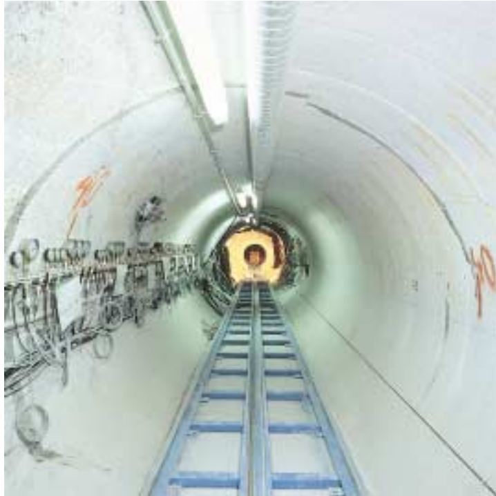
Figur 5-3. Interiör från det schweiziska berglaboratoriet i granit i Grimsel.
