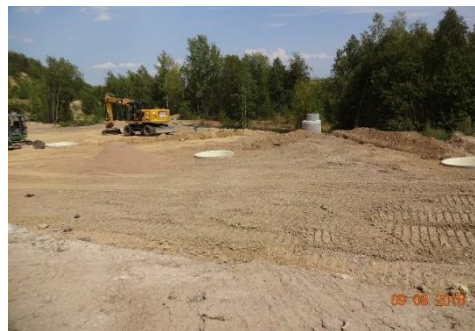
Výstavba betonových plochých lysimetrů („betonových mís“) na testovacím poli pro zachycení prosakující vody (PP4 SAXONIA Standortentwicklungs – und – Verwaltungsgesellschaft mbH)
