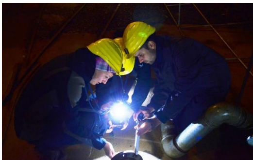
Průzkum zařízení na geotermální energii důlních vod (Dr. Thomas Grab, TU Bergakademie Freiberg)
