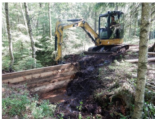
Stavba hráze v Stengelhaide, Sasko (datum pořízení snímku 01.06.2018)
