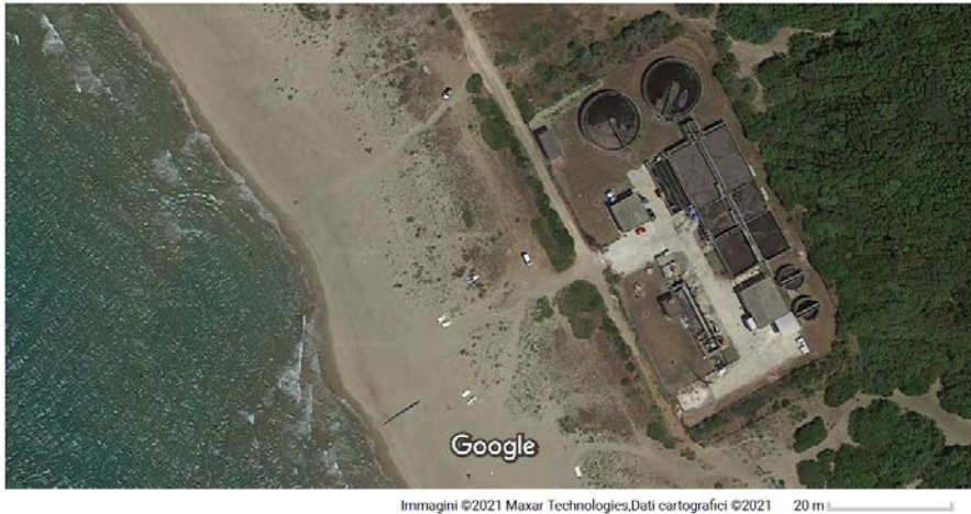
Figura 5: Il Depuratore di Cavallo Morto nel comune di Anzio (da Google Maps).
