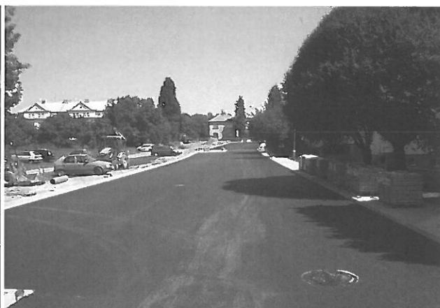
Zahradní ulice po rekonstrukci
