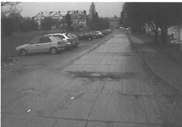
Původní stav Zahradní ulice
