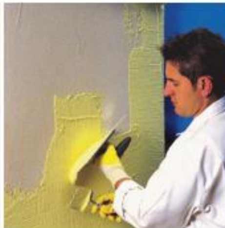
Obr.3 Nanesení omítky nerezovým hladítkem.
