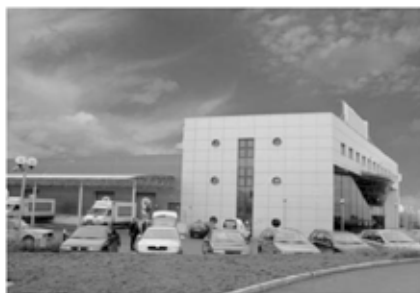
Obr. 9 Skladová hala na okraji Prahy
