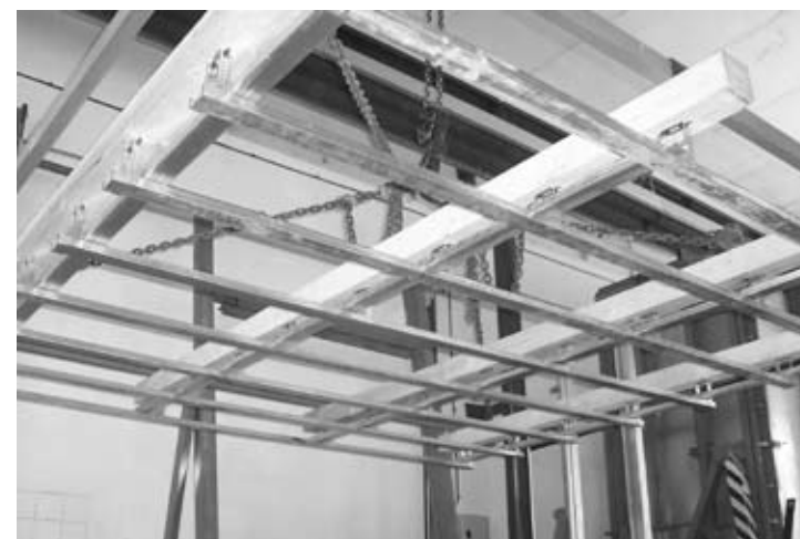
3. Montáž nosné konstrukce rošt z CD profilů
