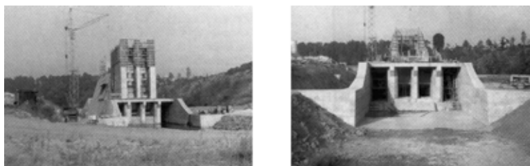
Obr.4a-4b – Vodní dílo Trnávka – betonáž sdruženého funkčního objektu
