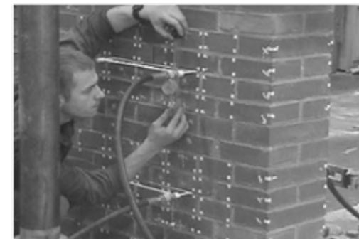
OBR. 4 Meranie stavu napätosti na murovanej konštrukcii
