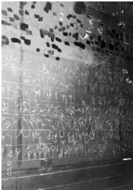
Obrázek 1 - Rastrové linie na dílcích, po 200 mm. Označené vady jsou v horní části obrázku po vybroušení.
