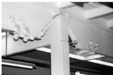
Obr. 13 Oprava porušené části střešních vazníků ocelovými táhly
