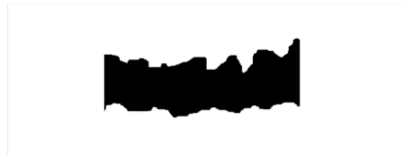
Obr. 3. Tvar trhliny – zpracování fotografie pořízené pomocí mikroskopu na počítači
