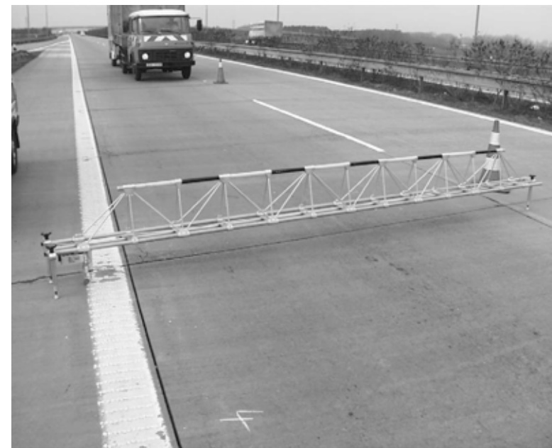
Obr. 10 Měření příčného profilu prohnuté CB desky na D11 při omezení provozu.
