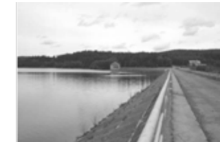
Obr.1a-b – Vodní dílo Landštejn, koryto bezpečnostního přelivu a návodní líc hráze
