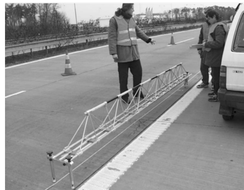
Obr. 11 Měření podélného profilu porušené CB desky přes příčnou spáru a rohy desky poškozené ASR.
