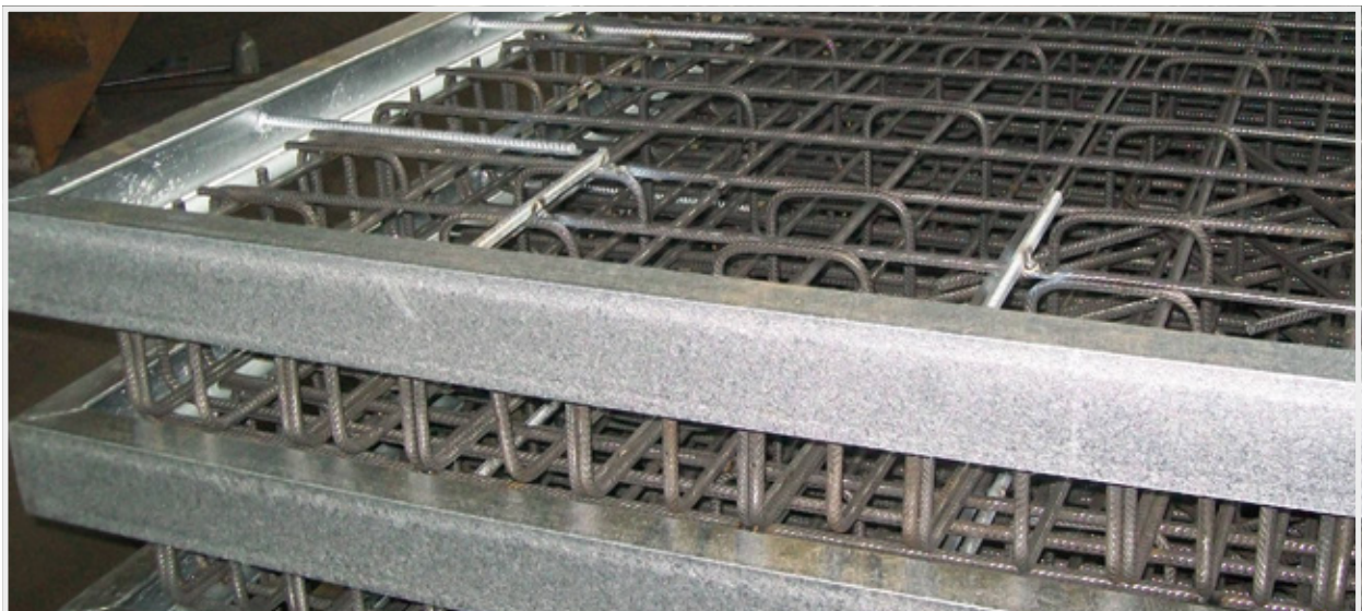
<montierte Kantenschutzprofile an Deckenplatten>
