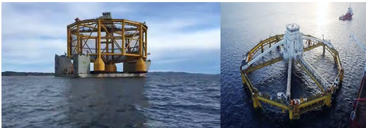
Figura 11. Ocean Farm 1 transportado a Noruega luego de construirse en China. Vista isométrica Ocean Farm 1 .
