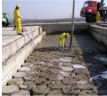
Betonáž na úložišti v Dukovanech
