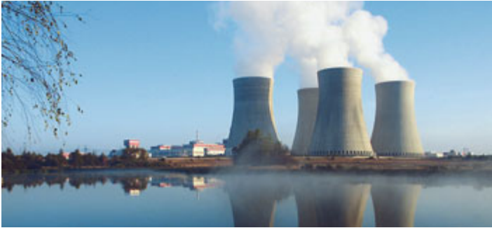
Jaderná elektrárna Temelin
