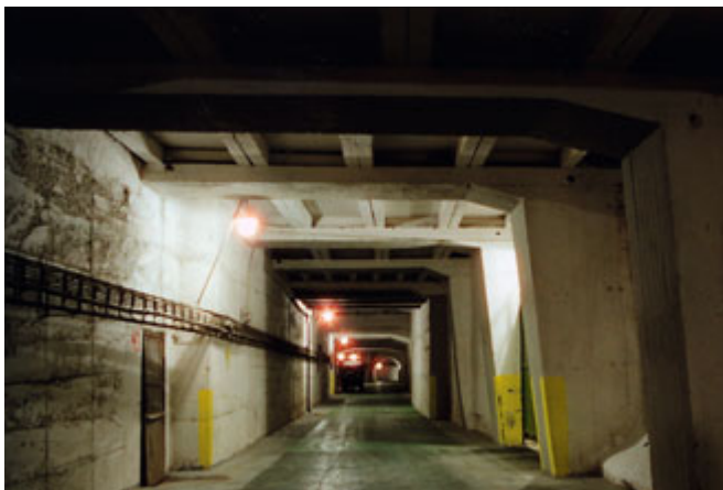
Dopravní chodba úložiště Richard
