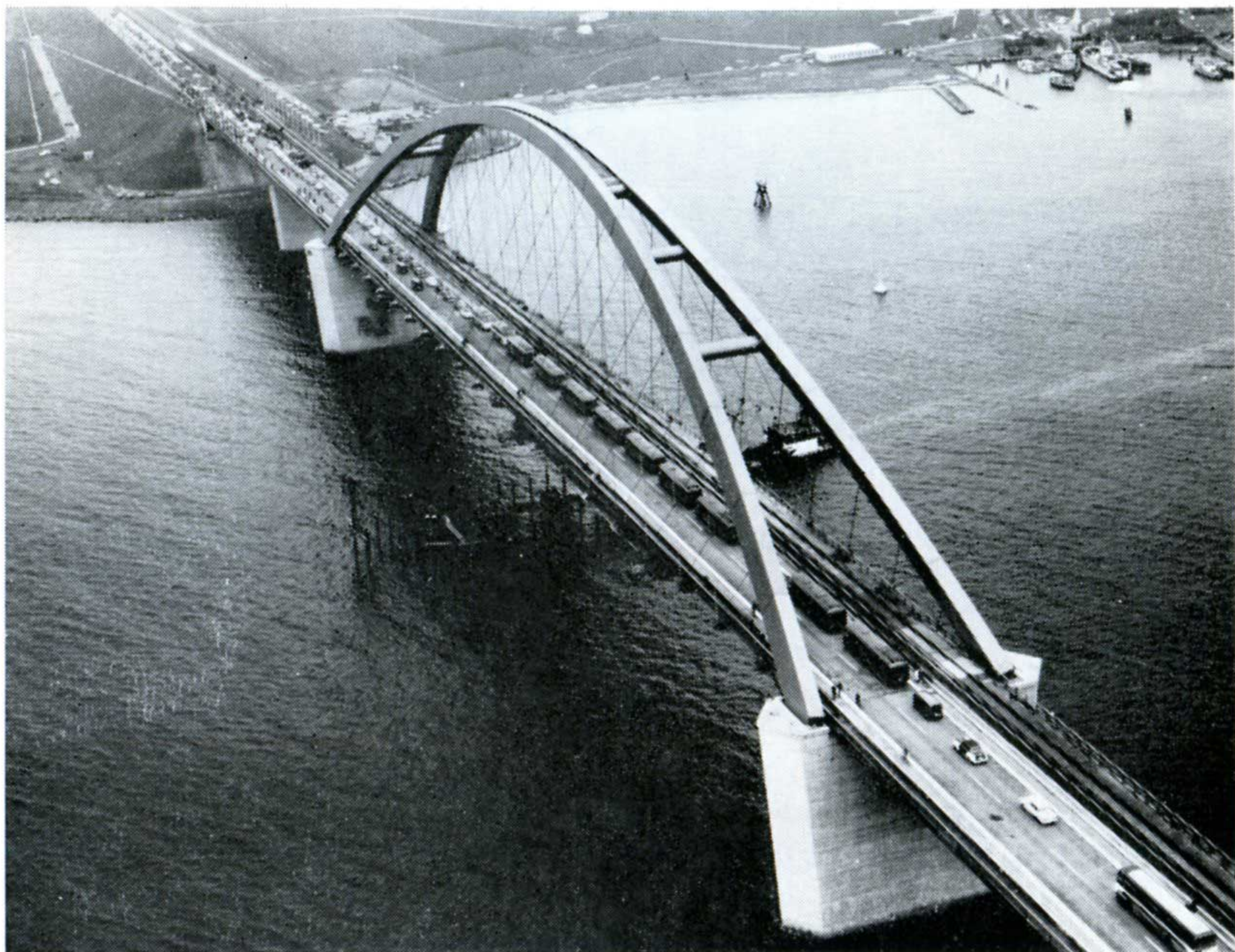
Vue aérienne du pont sur le Fehmarnsund dont la pureté de ligne est remarquable. (Photo D.B. — Hamburger Aero-Lloyd)
