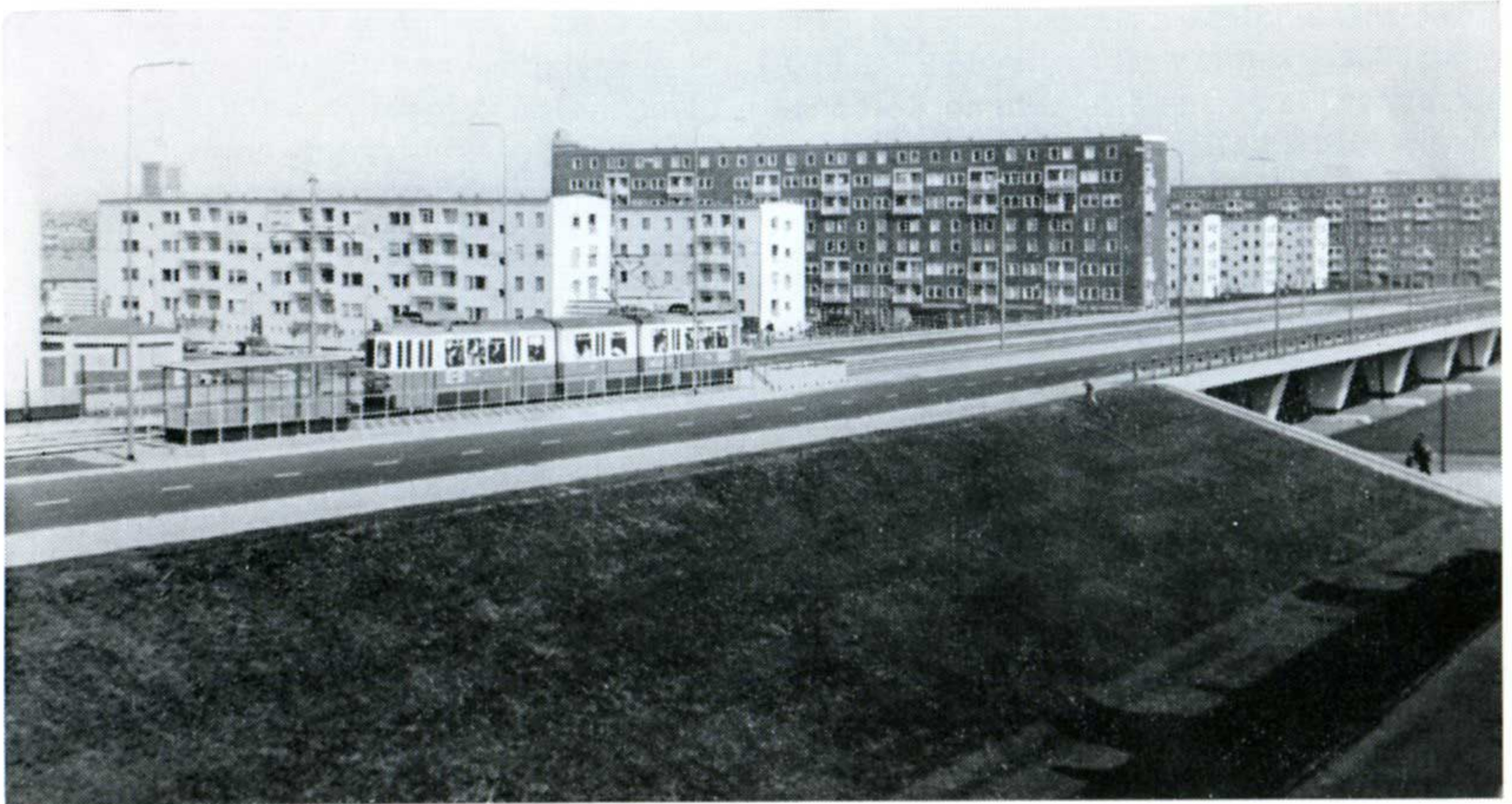
Amsterdam, ligne 17 — autoroute sur remblai et point d'arrêt avec ses abris, ses quais et ses escaliers conduisant à la chaussée inférieure passant sous l'autoroute. (Photo de l'auteur)
