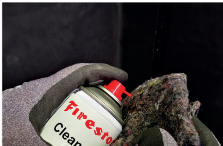
Die EPDM-Folie mit Firestone Reinigungsspray (Cleaner) C-20 oder Firestone Reiniger (Clear Splice Wash) gründlich reinigen. Auch die EasyCorner reinigen, falls diese verschmutzt ist.
