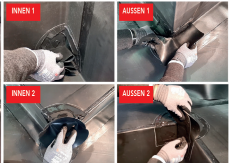
Das Eckformteil auf falten und aufsetzen.
