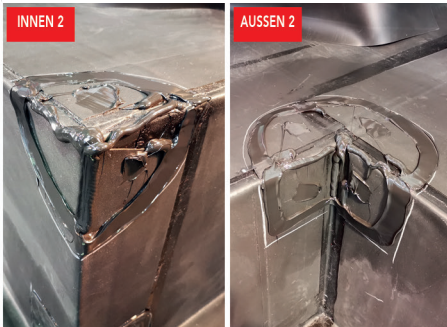
Mit einer biegefähigen Blattspachtel aus Stahl die äußeren EasySealant-Stränge vorsichtig flachdrücken. Überschüssiges EasySealant kann auf Flächen ohne EasySealant abgestreift werden.
