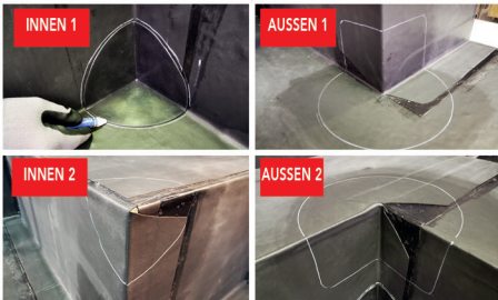
Verlauf des Eckformteils mit weißem Markierungsstift anzeichnen.
