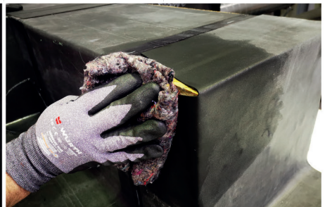
Die EPDM-Folie mit Firestone Reinigungsspray (Cleaner) C-20 oder Firestone Reiniger (Clear Splice Wash) gründlich reinigen. Auch die EasyCorner reinigen, falls diese verschmutzt ist.
