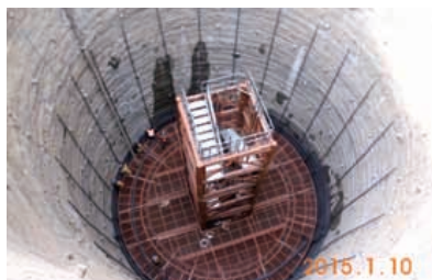
基礎鋼筋組立
