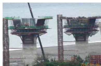
金崙 P9-P10 柱頭節塊鋼筋綁紮及內模支撐搭設
