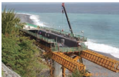
多良 U2-2 (P6~P7) 箱型梁鋼筋綁紮
