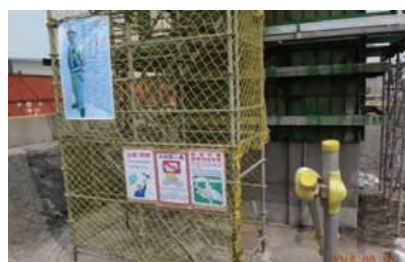
上下設備佈設安衛標誌，宣導安全
