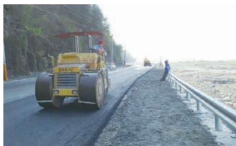
「台 27 線 20K+200~21K+330(含六津橋)改善工程」20K+200~21K+020 瀝青混凝土鋪築
