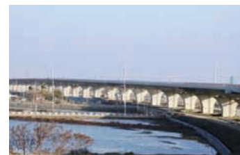
東西向快速公路北門玉井線E707-3標獲金路獎傑出工程類第4名
