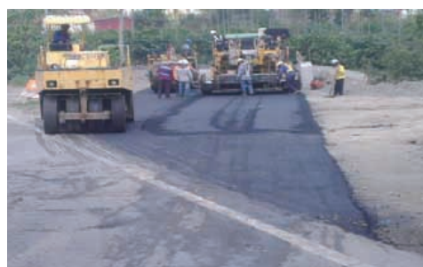
「台 27 甲線(六龜)2K+500~3K+000 路基路面拓寬工程」交通維持便道瀝青混凝土鋪築
