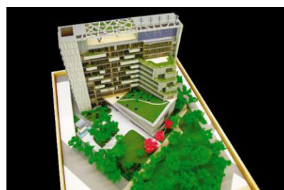
辦公大樓地上 12 層鋼結構及地下 2 層（RC 及 SRC）
