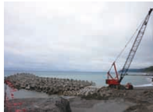
海岸旁施工情形，以人工養灘方式維護海岸線
