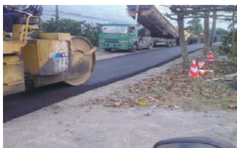
「台 27 甲線(六龜)2K+500~3K+000 路基路面拓寬工程」交通維持便道瀝青混凝土鋪築
