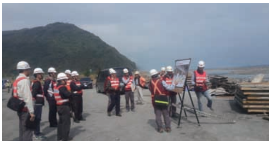
工地安全稽核照片
