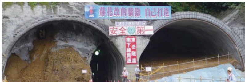
東岳隧道南下線主隧道全線貫通
