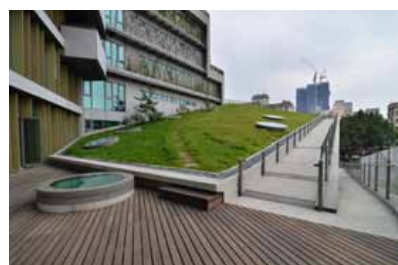
外牆立體綠化及屋頂平台、陽台綠化
