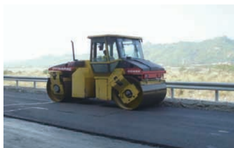
「台 27 線 20K+200~21K+330(含六津橋)改善工程」20K+200~21K+020 瀝青混凝土鋪築
