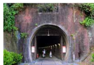
台2線福隆至頭城路線景點介紹 - 舊草嶺自行車隧道
