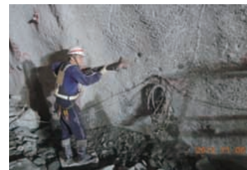
工程人員進行岩栓扭力試驗
