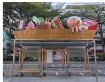
修繕及整併老舊公車候車亭
