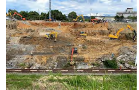
高鐵維修人員執行現場搶修工程
