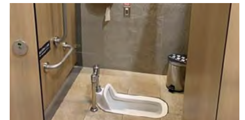
全線車站蹲式廁間加裝扶手
