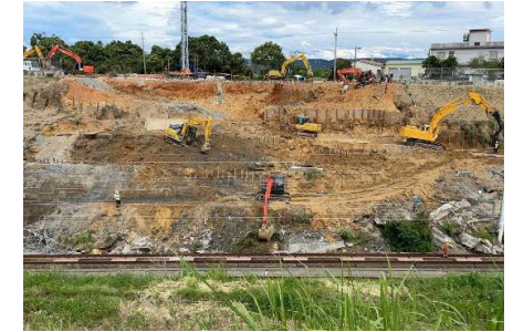
高鐵維修人員執行現場搶修工程
