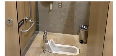
全線車站蹲式廁間加裝扶手
