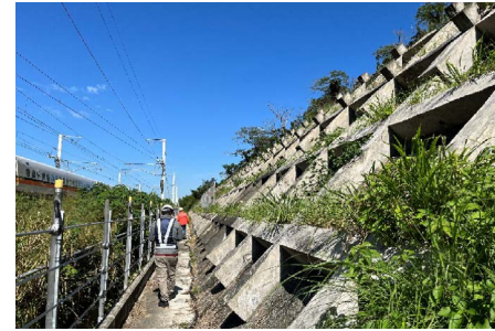
委託技師進行邊坡現場勘查
