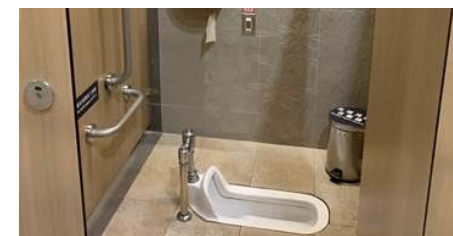
全線車站蹲式廁間加裝扶手
