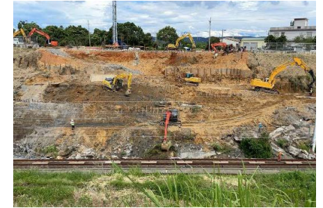
高鐵維修人員執行現場搶修工程
