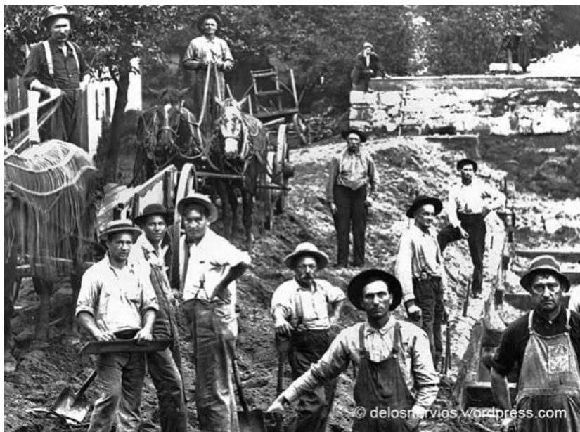
Figura 10. Grupo de obreros europeos trabajando en el Canal Francés.
