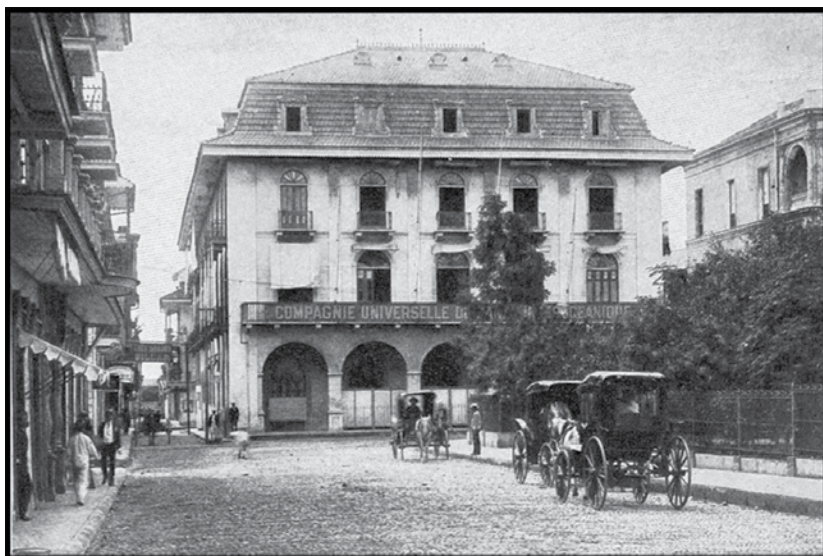
Figura 6. Edificio de La Compañía Universal del Canal Interoceánico. Antiguo Grand Hotel del Casco Viejo.
