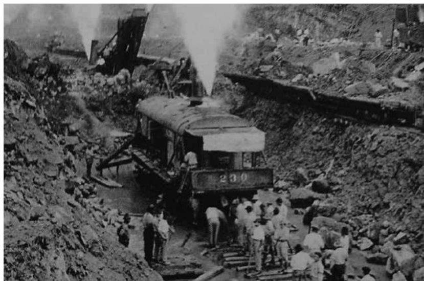
Figura 15. Los estadounidenses reinician los trabajos del Canal.
